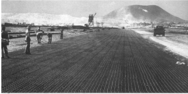
Construction d'une piste recouverte de chrome de fer compacté - Magenta ( *Les Transports*, p. 22 )
